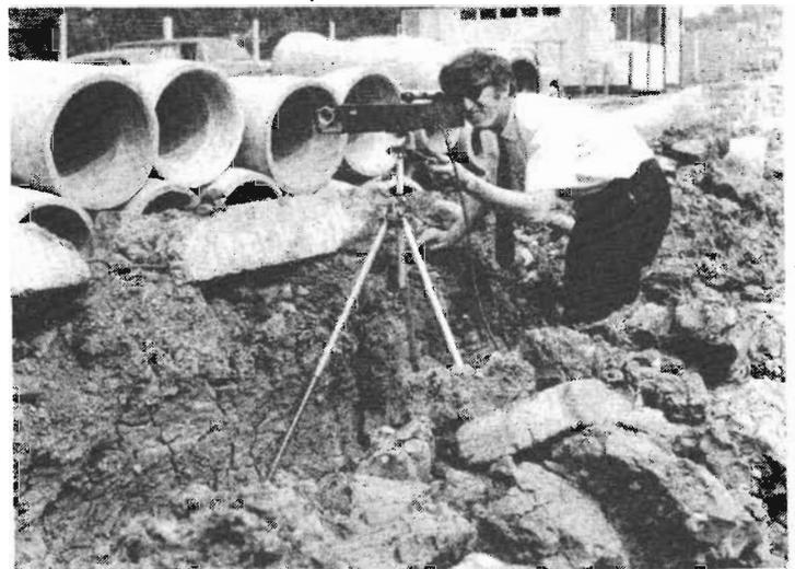
Photo n° 6 : Le Laserline de Marconi-Elliott trouve de multiples usages dans les travaux publics : pose de canalisations, construction de builgins, observation des mouvements de train dans les tunnels et les mines, etc.
