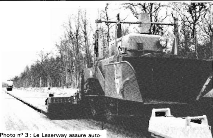
Photo n° 3 : Le Laserway assure automatiquement le guidage en nivellement des engins de travaux publics. On voit, au premier plan, l'émetteur laser ; le récepteur est fixé sur l'engin. Le système est fabriqué par la Cilas et commercialisé par la société française Blaw-Knox.
