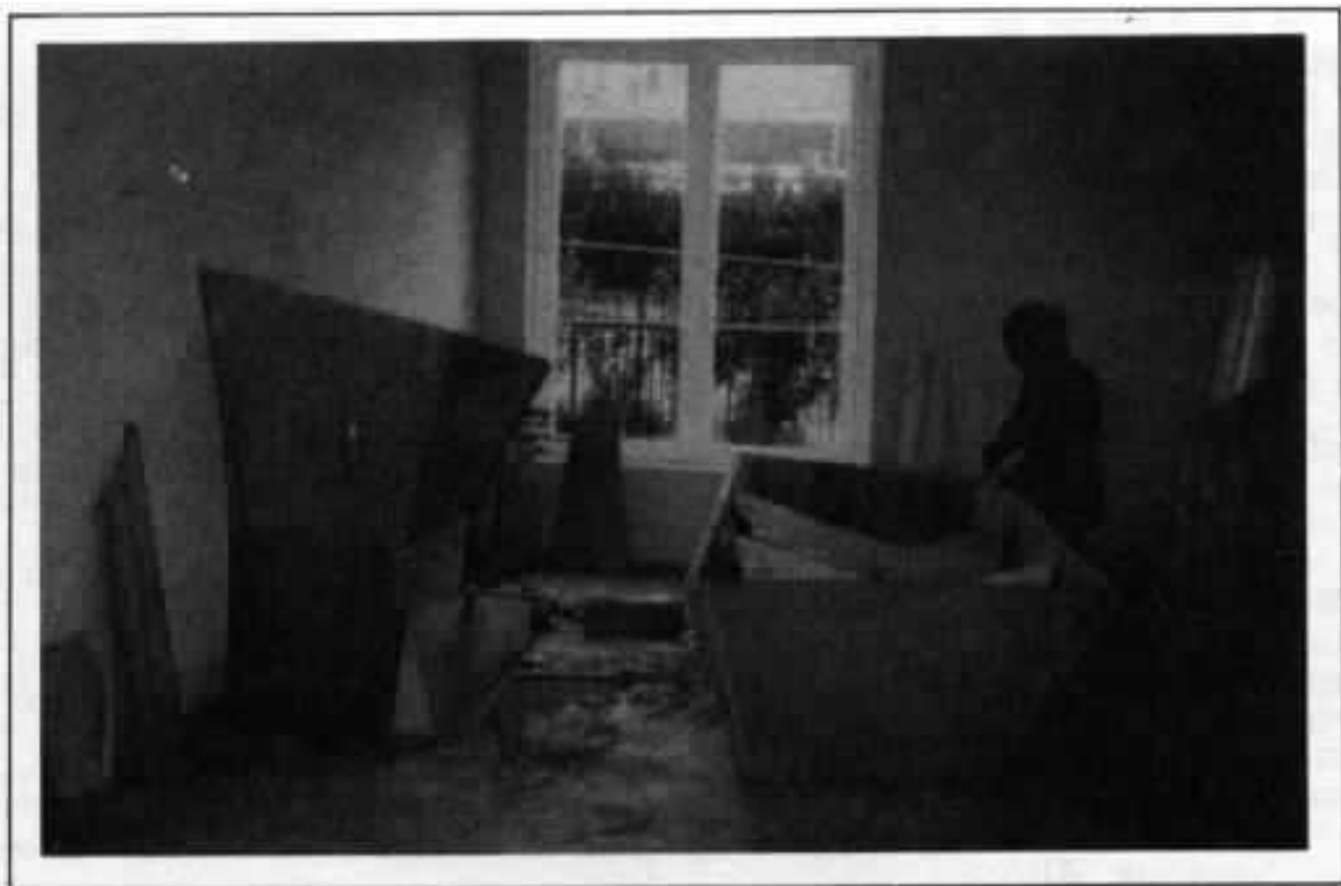
Le pavillon en cours de construction.
