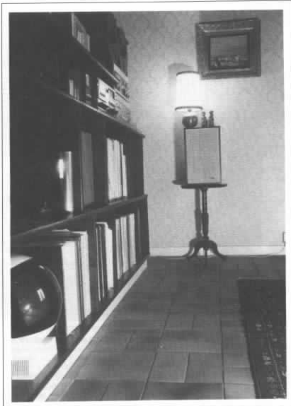
Fig 5 - Détail du sol : Grès d'Artois (11 X 22 cm) posé de façon très irrégulière à joints larges et creusés. Les tapis recouvrent environ le tiers de la surface du sol.
