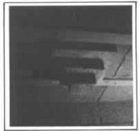
Détail plafond studio.
