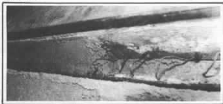
Finition en cours du joint en haut du mur (cf. texte).
