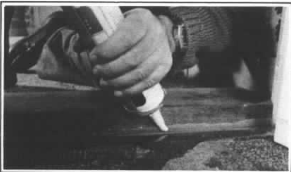
Pose d'un joint d'étanchéité au bas d'une porte. Le seuil extérieur permet une bonne isolation sur les quatre côtés.
