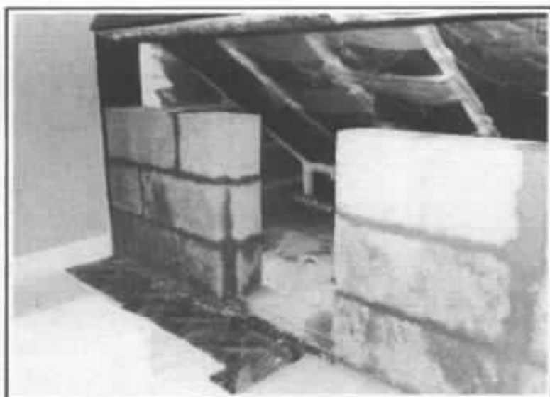
Sur le mur AV il a été prévu l'emplacement de HP de 38 cm qui permettront l'évolution vers un système utilisant 100 % de pavillons.
