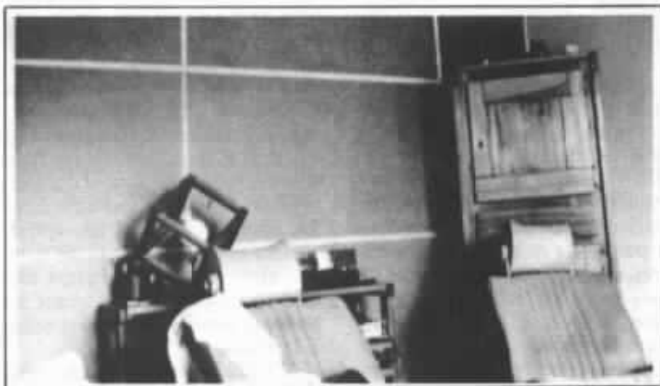
Fig. 4 : Le local ayant servi aux tests, après traitement du mur arrière avec de la fibre de roche. La finition qui recouvre l'ensemble de ce traitement n'a pas encore été effectuée.
