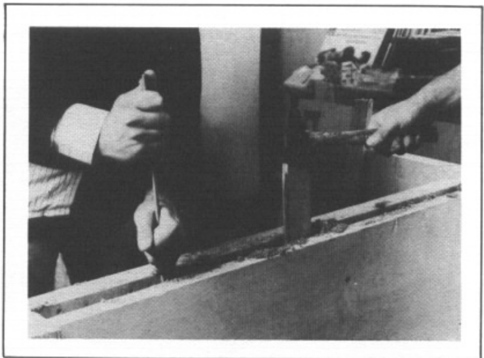
Photo 7 : Sablage de la face arrière. C'est le procédé qui est décrit dans le texte : à gauche la longue tige filetée « fore » et parfait le remplissage ; à droite le tasseau sert à bourrer. On remarquera une tête de vis sur la face arrière servant à la fixation du renfort de Nantex 30 de dimensions 400 × 80 mm et qui permet de percer la face arrière sans avoir à traverser le sable pour le passage du câble de modulation.
