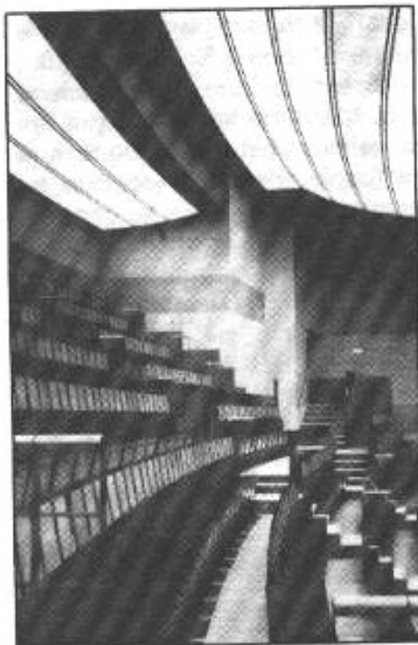
Fig. 3 : La partie arrière de la grande salle, son deuxième balcon. Les sièges relevés présentent des caractéristiques d'absorption proches de celles de l'être humain et le revêtement en granit accroît la durée de réverbération.
