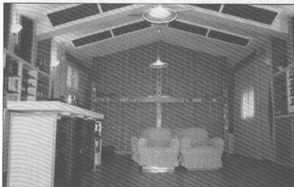
Fond de la salle fortement absorbant masqué par une paroi acoustiquement transparente.
