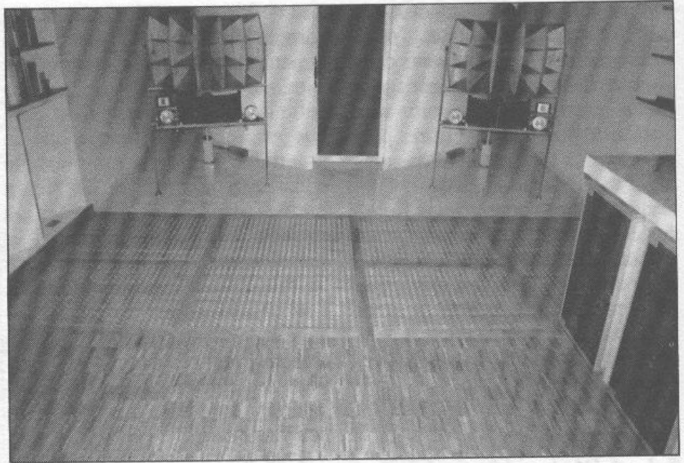
Plancher avec zone semi-absorbante. Il élimine les réflexions primaires provenant du sol.
