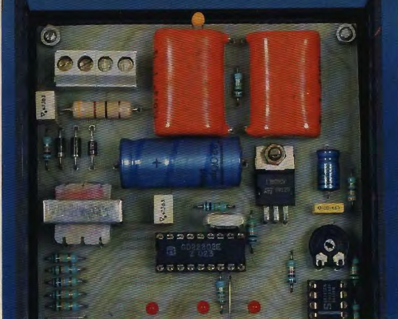
Photo 3. – On aperçoit les condensateurs de l'alimentation.
