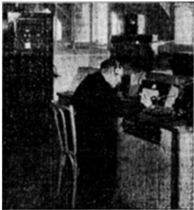
Salle de contrôle d'émission radiotélégraphique des services techniques.
