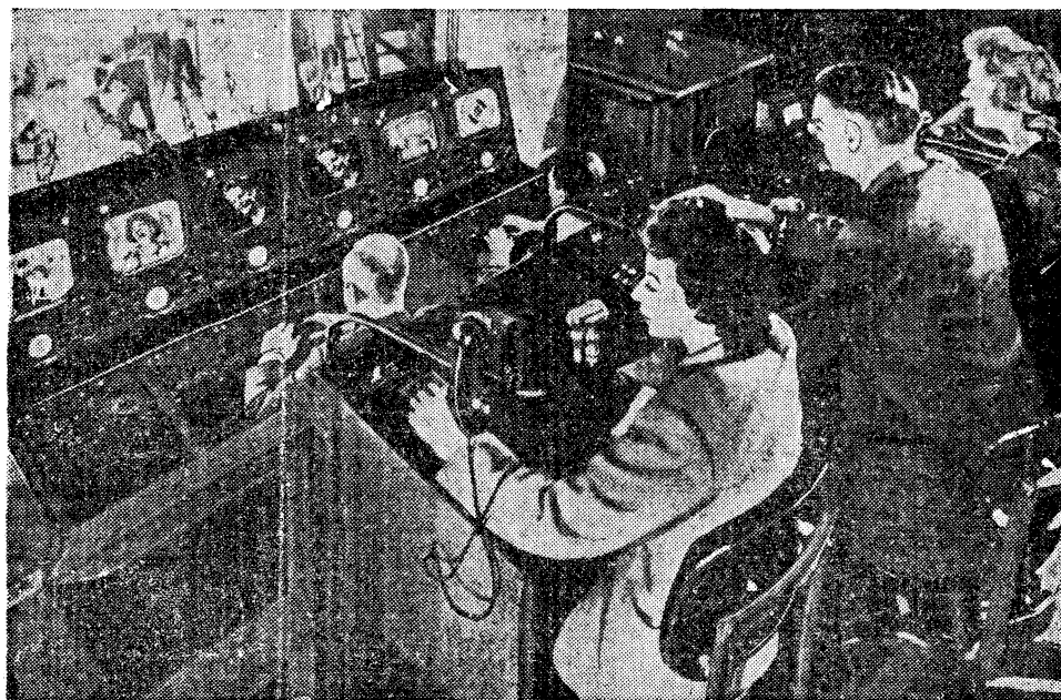
La salle de contrôle de la station de télévision WRGB, de la General Electric. Au fond, on aperçoit un studio d'émission en direct.
