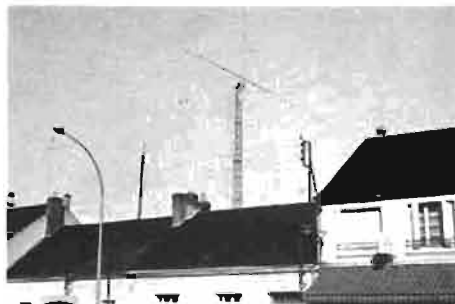
FIG. 5. — Antenne six éléments 14 MHz. Longueur du boom 17 m, hauteur du poinçon de soutien 6 m, hauteur du pylône 19 m. Chaque élément est coupé par un nylon en vue du fonctionnement sur 7 MHz. Un relais assure la commutation en 14 MHz. Rapport avant-arrière : 18 dB ; en pointe : 35 dB.
