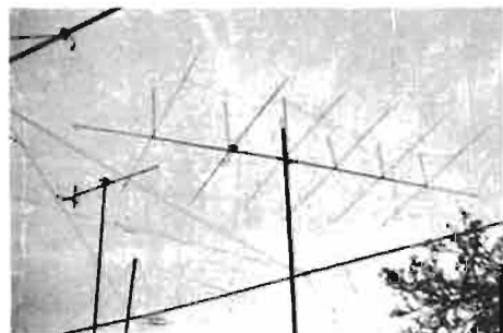
FIG. 3. — Antenne six éléments 28 MHz.
