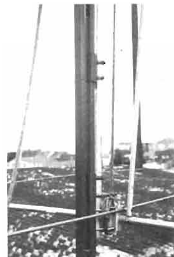
FIG. 2. — Détails du poteau en tube de l'antenne 28 MHz. Deux tubes carrés sont soudés à un centimètre l'un de l'autre. Ce sont deux morceaux de tube carré de la taille au-dessus qui coulisent librement sur l'un des tubes qui forment les coulisseaux. Deux colliers atlas tiennent le poinçon en tube alu. Le raccordement de l'élément est visible. Un collier atlas sur le boom et un sur le poinçon.
