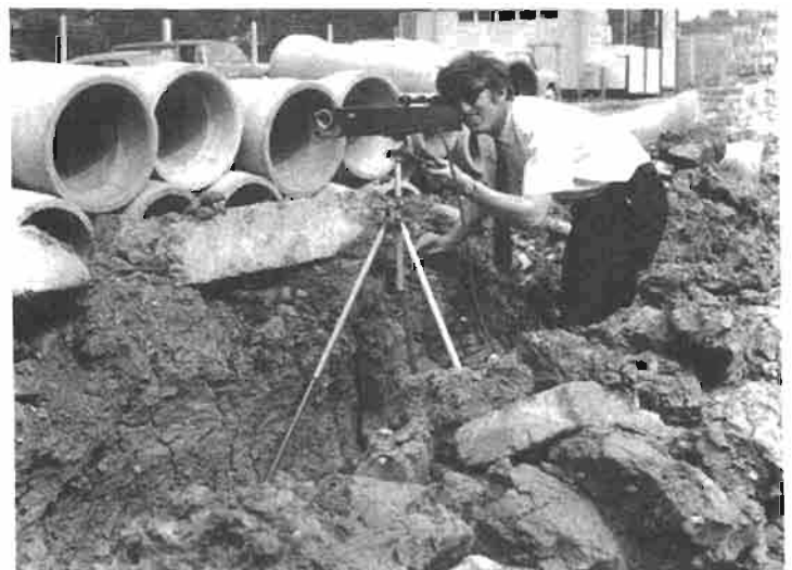
Photo n° 6 : Le Laserline de Marconi-Elliott trouve de multiples usages dans les travaux publics : pose de canalisations, construction de bulgings, observation des mouvements de terrain dans les tunnels et les mines, etc.
