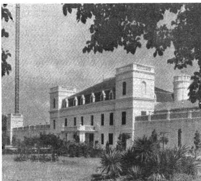
1934 : Le château St-Aignan abrite les nouvelles installations techniques.
