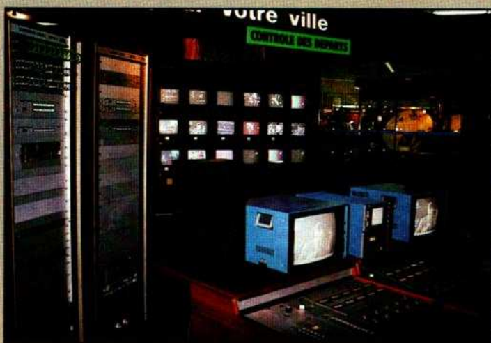
Tête de réseau câblé selon TDF, au fond, les écrans de contrôle, au premier plan, la régie de contrôle, à gauche, les baies de contrôle.
