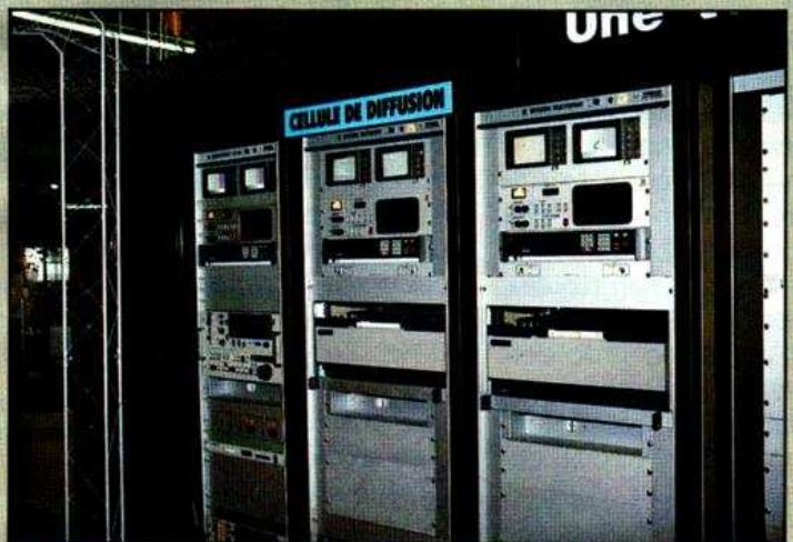
Les cellules de diffusion, chacune dispose de deux magnétoscopes, dans un avenir proche, les machines de lecture disposeront d'un changeur.
