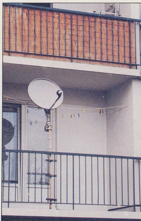
Ensemble motorisé sur balcon : c'est possible...
