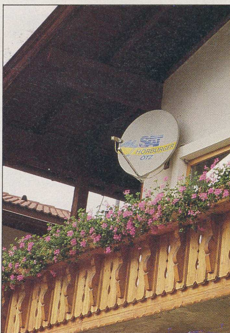
Montage sur balcon : l'idéal pour le câblage et le pointage !
