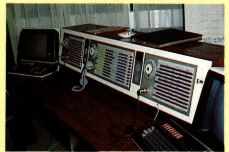
Fig. B : Salle d'appels (18). Un groupe de position appels 18 sur les standards aux extrémités lignes directes avec les C.S. au centre.
