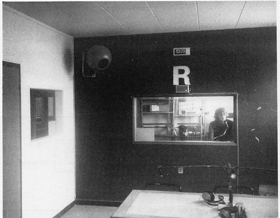
« DIJON-CAMPUS » 94,7 MHz, studio n° 1. Photo n° 1 — Vue générale du studio et de la cabine. A gauche, porte d'entrée et vitre « visiteurs ». En haut au loin, le haut parleur
