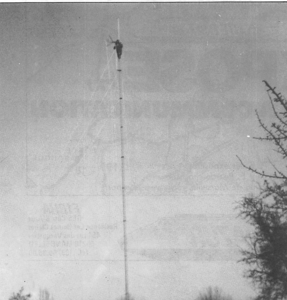
Montage des antennes sur le pylône.
