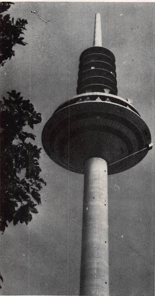
Pylône du centre émetteur de FRANKFURT
