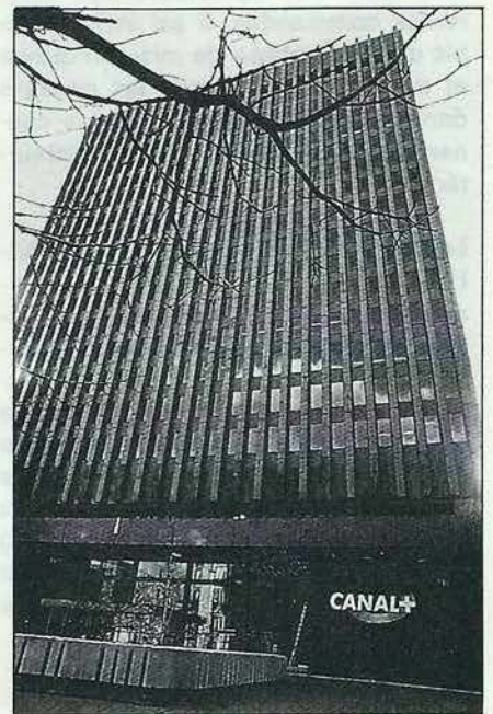
Photo 1 : L'immeuble de Canal+ au 76, rue Olivier de Serres à Paris dans le 15 ème arrondissement.
