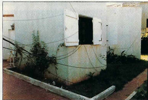
Quelques arrivées de coax, 1000 mètres furent utilisés.
