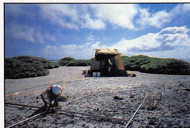
Montage d'une beam sur le site CW.
