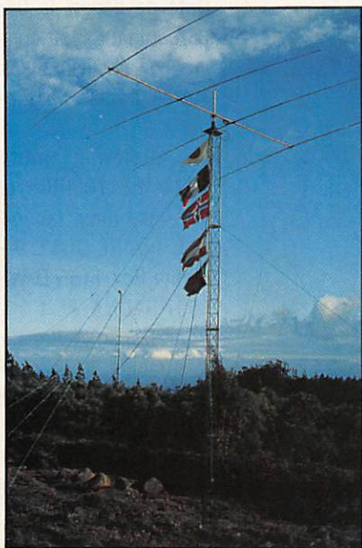
Antenne 20 m terminée.
