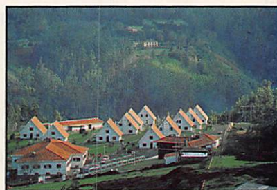
Le QTH. Les shacks sont dans les bungalows à droite, à côté les antennes.
