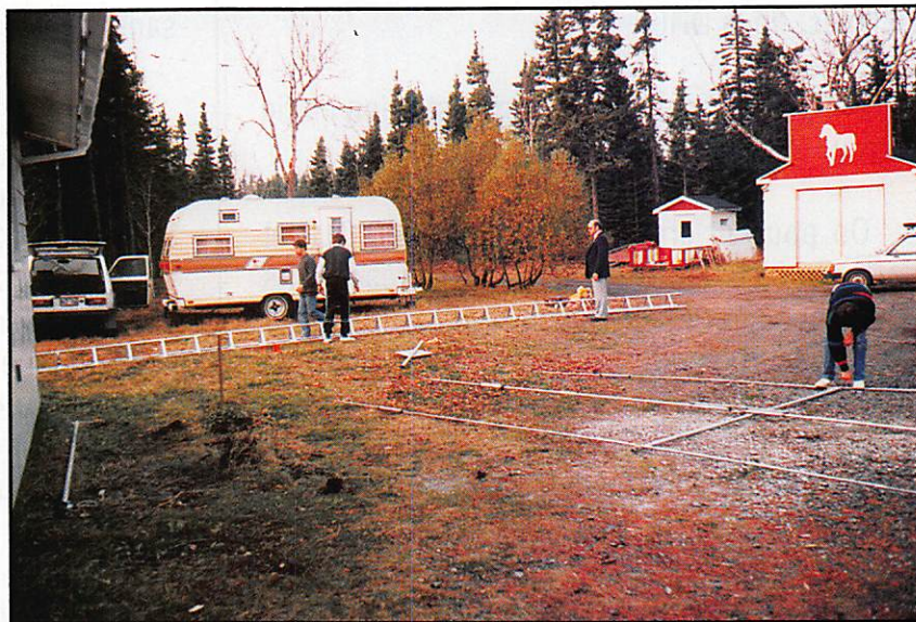
Montage des aériens. VE2OFL, VE2LIT, VE2NN et VE2BAP.
