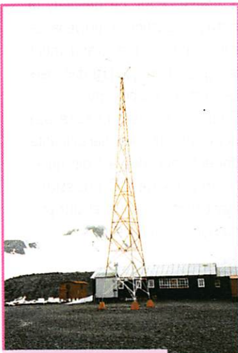
Un beau pylône !
