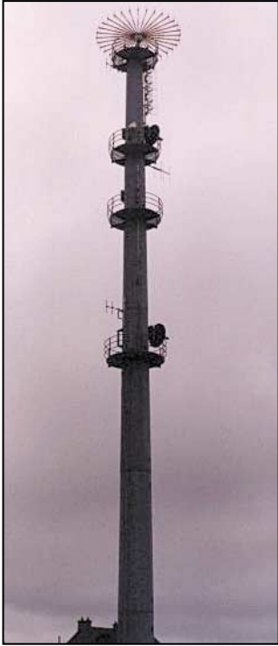
Les antennes du CROSS Jobourg.
