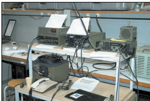
Station radio (HF à gauche, VHF à droite) pouvant être reliée au Sicile.
