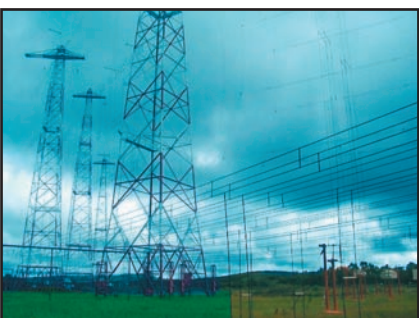
5 - Antennes rideaux de Radio Nederland (en bas à gauche, ligne symétriques 300 ohms)
