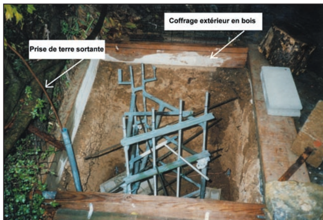
Photo n° 10 : Chaise prête à être coulée.
