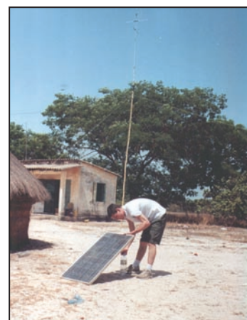
5 - J'installe un panneau solaire, pour recharger une batterie qui sert au poste de l'armée.
