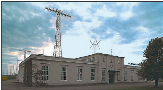
1 - La station radio Varberg (© Riksantikvarieämbetet).
