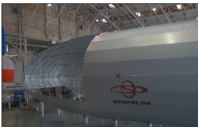
2 - Le Sanswire One en cours de construction.
