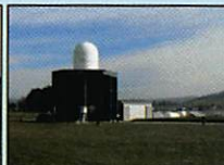
Le bâtiment de gonflage de Météosuisse à Fagnolle. On aperçoit un ballon en cours de gonflage à l'extérieur de l'édifice.
