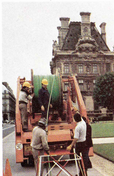
Installation du câble reliant le centre de télécommunications des Tuileries à celui de la place Philippe-Auguste. (Doc. Score/DGT)
