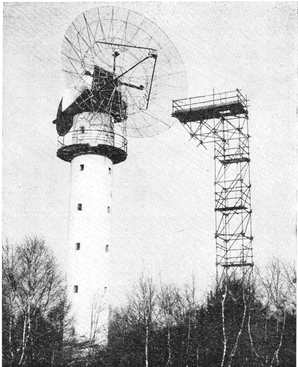
La station de réception des télécommunications par satellite s'élève à Nançay (Cher) en pleine Sologne. Une tour de 20 m de haut abrite la chambre où ont été reçus les signaux modulés émis par les ingénieurs de la Bell Telephone depuis les laboratoires de Holmdel, sur la côte américaine de l'Atlantique, et réfléchis par le satellite américain Echo I lancé le 12 août 1960 à Cap-Canaveral. (Photo C.N.E.T.)
