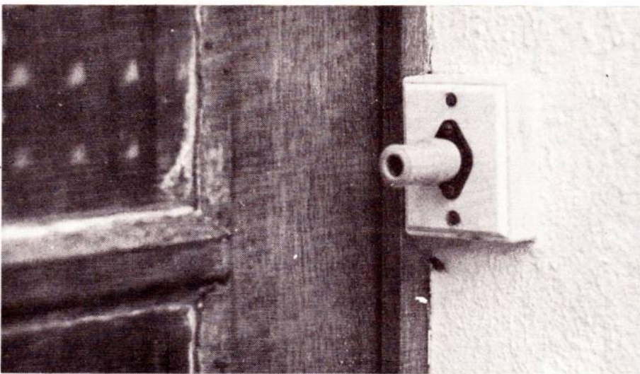
Une disposition possible pour le support de fiche servant de serrure
